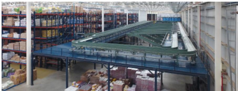
**4. Almacén Pallet Shuttle:** se han instalado dos niveles de estanterías por compactación con el sistema Pallet Shuttle semiautomático en una entreplanta ubicada delante de los muelles de carga. Tienen capacidad para 512 palets de productos de alta rotación (tipo A).
