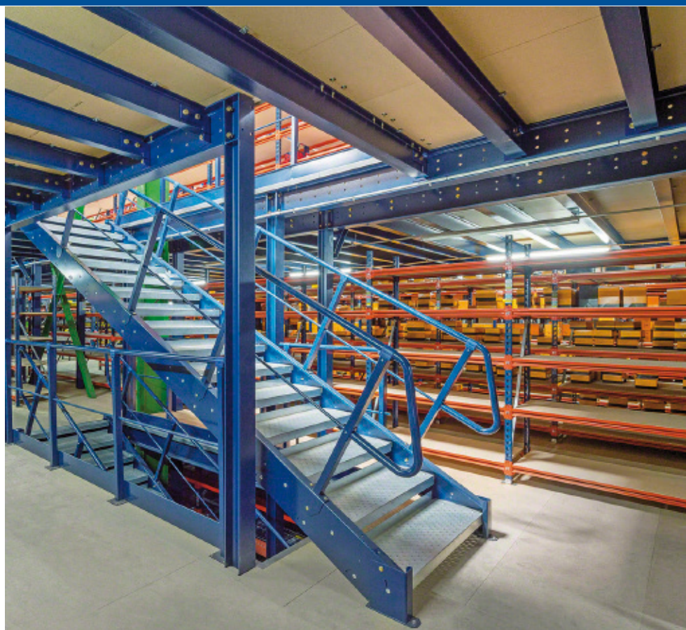
Piso de tablero aglomerado melaminado MA/ML
