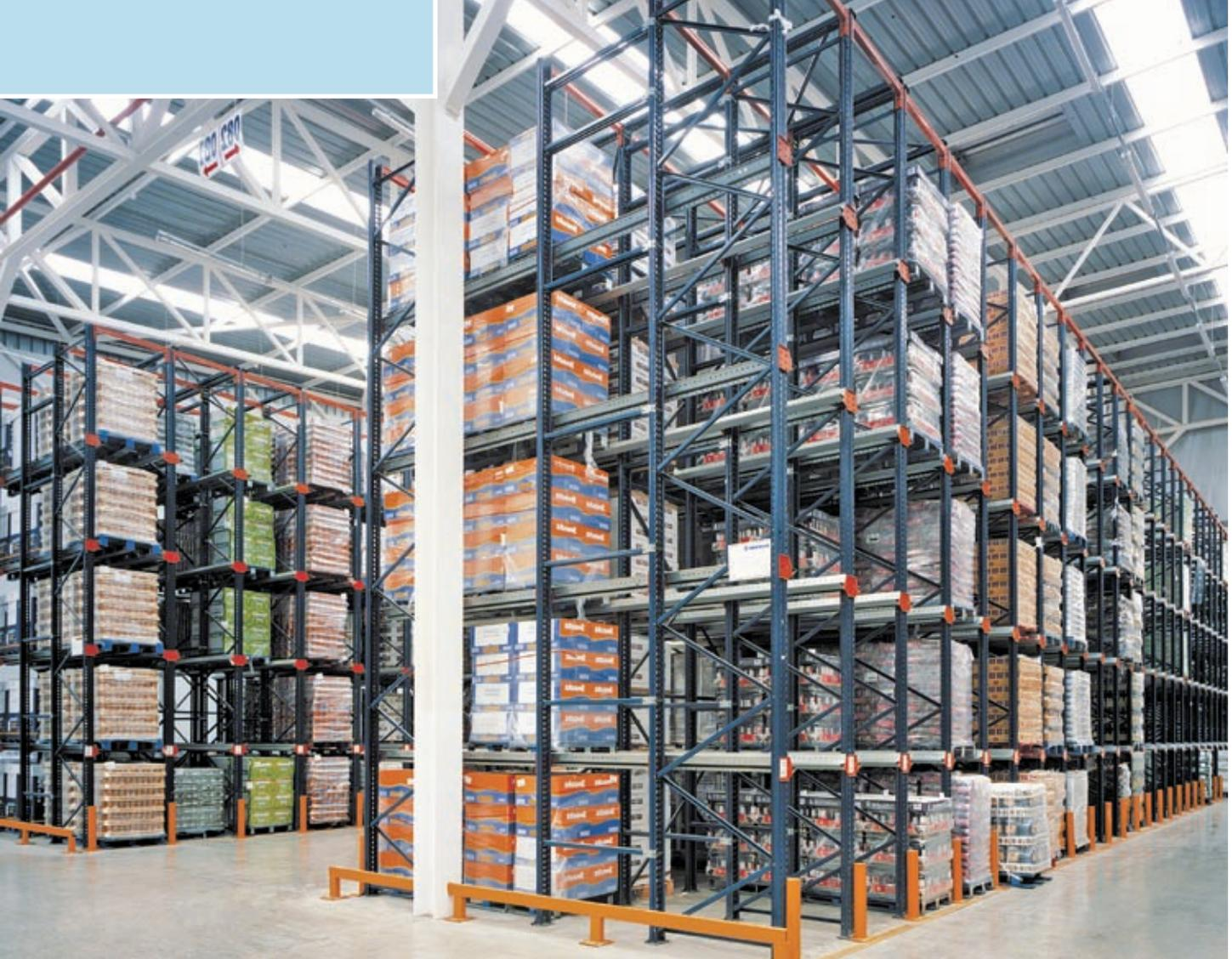
Además de lo considerado en el sistema constructivo 1, se colocan calles de rigidización y arriostados superiores que transmiten los esfuerzos horizontales directamente al suelo.
