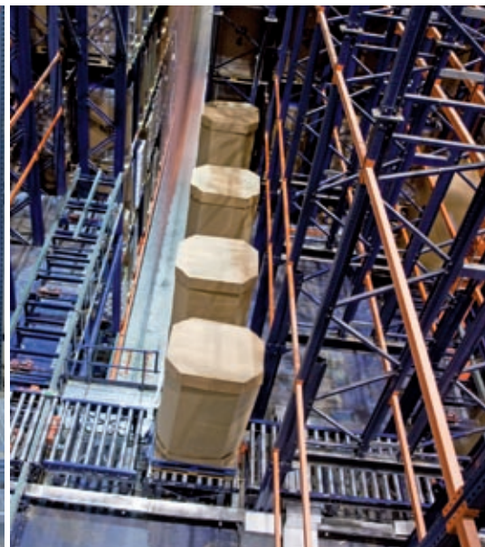
Transportadores de pasillo de almacenamiento.
