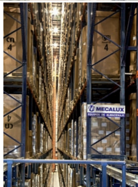
Pasillo de almacenamiento con transelevador.
