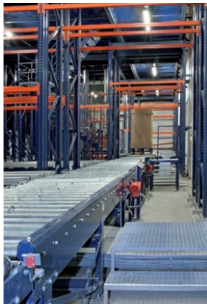
Transportador de comunicación en el interior de la cámara.
